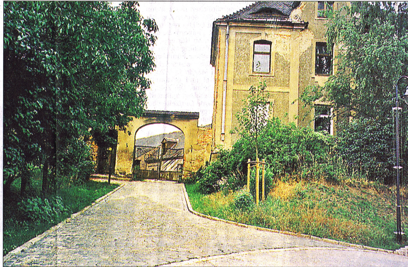
Hier sieht man die Toreinfahrt zum Tauchaer Schloss. Das einstigen Herrenhauses rechts vom Tor ist noch einigermaßen in Ordnung. Dort könnte zuerst mit einer schrittweisen Sanierung begonnen werden. Fotos (2): Dieter Altmann
