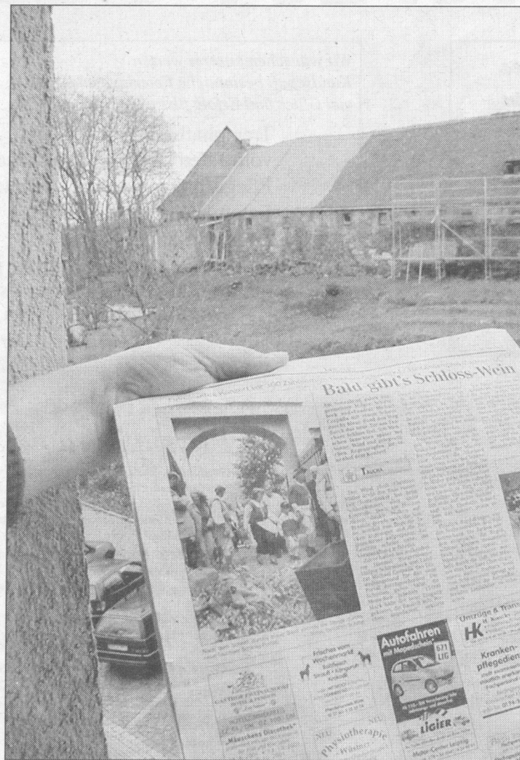
Im Frühjahr wurde das neue Schlossportal eingeweiht und nun gehen die Arbeiten an den Gebäuden langsam voran. Foto: K. Kirscht
