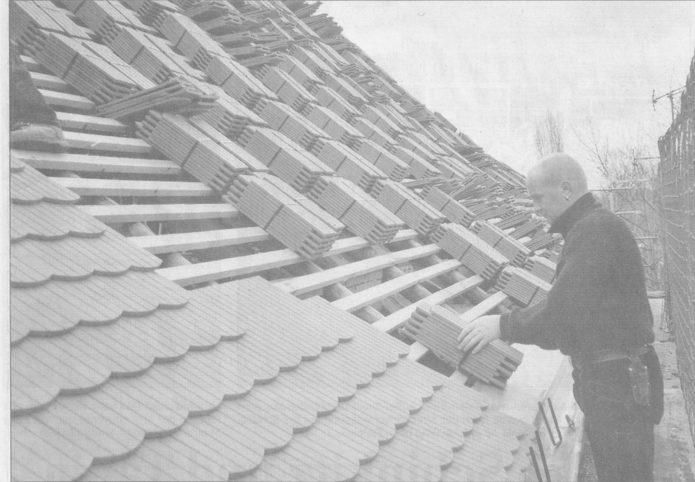
Dirk Steyer vom Bauzentrum Leipzig bei der Arbeit auf dem Dach der Tauchaer Schlossanlage.
