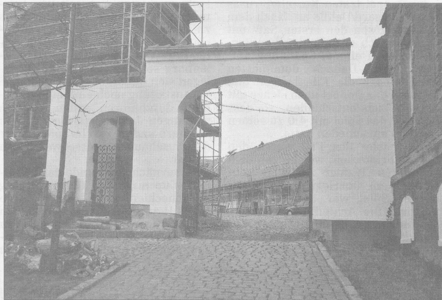
Der Blick durch das neue Eingangsportal am Tauchaer Schloss verrät, dass die Dächer einiger Gebäude im Innern der Anlage bereits um- und neu gedeckt sind.
