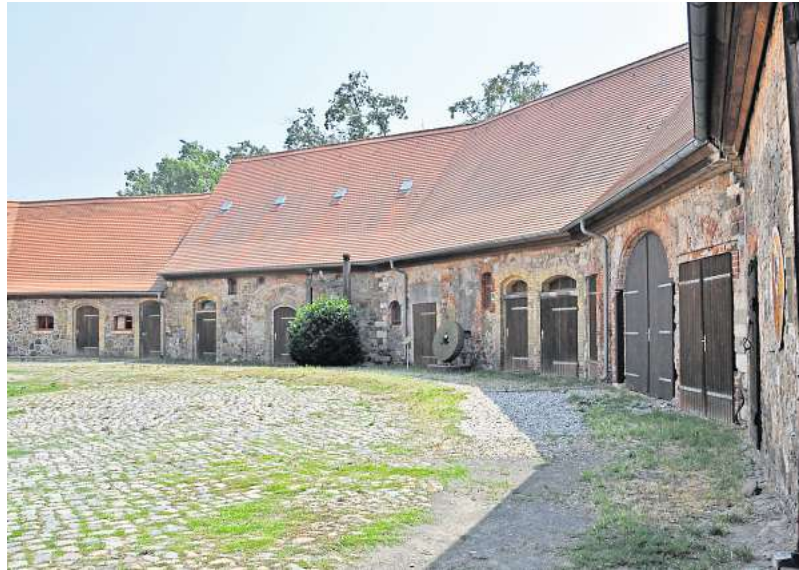
Ein Großteil des Gebäude-Ensembles des Tauchaer Rittergutsschlusses und der Hof sollen bis Ende 2021 saniert werden.
